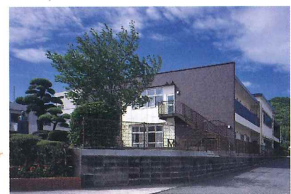
2016年に完成した鹿児島市皆与志町の「あさひが丘学園」の現施設。プライバシーに配慮した「小規模ユニットケア」を制度発足後いち早く導入した。
